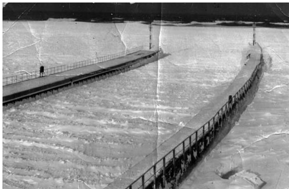
Zamarznęte wejście do portu, początek lat 60. Zdjęcie udostępnił biblioteka miejskiej śp. Edward Kubiak
